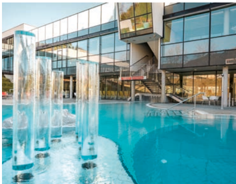
Therme NOVA Köflach © Die Abbilderei
