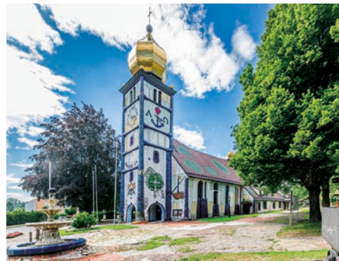
St. Barbara Kirche Bärnbach © Die Abbilderei
